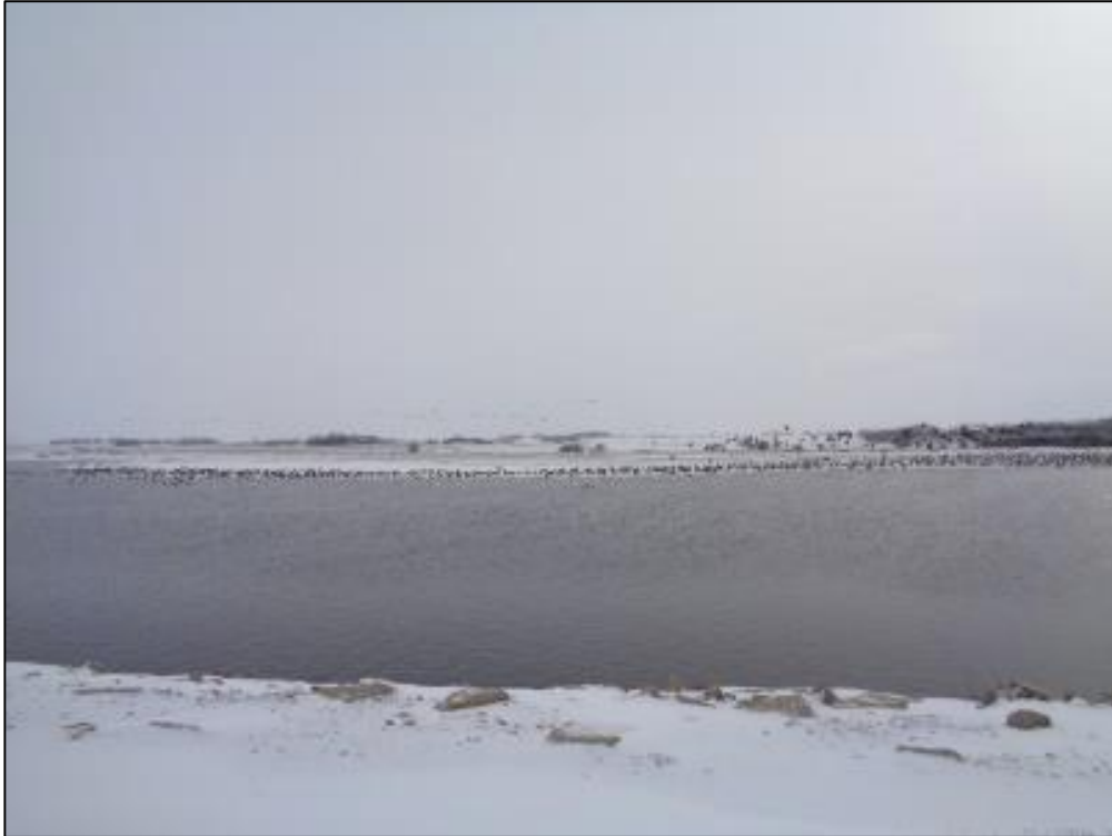
Effluent Lagoon – 6' Deep
